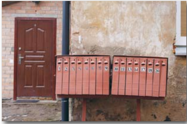
Plattenbauten und Bauernhäuser prägen die urbane Struktur außerhalb des sanierten Stadtkerns. Die eiserne Faust des Kommunismus hat in den heruntergekommenen Vororten erbarmungslos marodiert.
